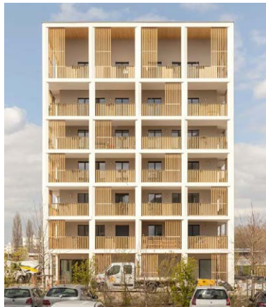
De buitenruimte en de beëindiging zijn onderdeel van het architectonische concept
