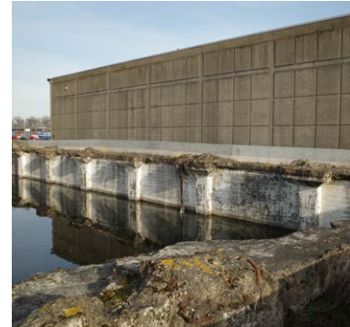
Huidige situatie kelderbak naast Loods Nederland
