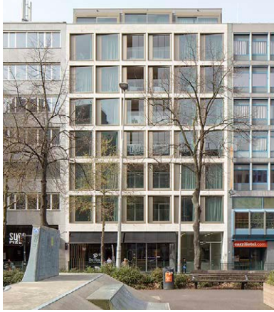
Geluidswerende voorzieningen zijn integraal onderdeel van het gevelontwerp
