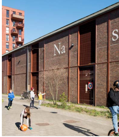
Bij transformatie blijft de karakteristiek behouden
