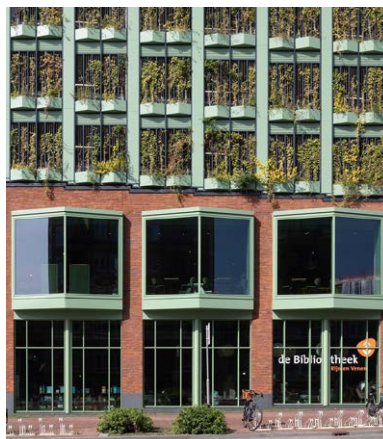
De functie is afleesbaar. De eigenheid en herkenbaarheid van het gebouw wordt hiermee versterkt
