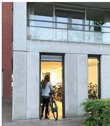
Fietsenstallingen zitten op logische posities en zijn goed zichtbaar en bereikbaar
