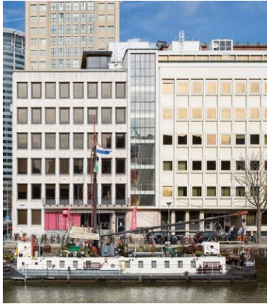
Bouvvolumes vormen op zichzelf een architectonische eenheid en vormen gezamenlijk een geheel
