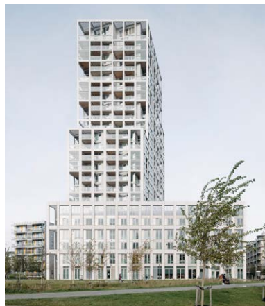
De buitenruimte is onderdeel van het architectonisch concept
