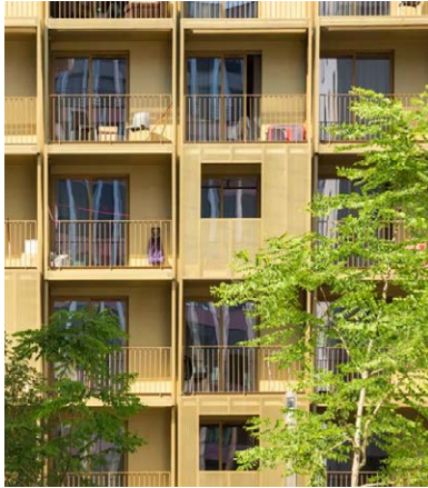
Buitenruimte is integraal onderdeel van het gevel-ontwerp
