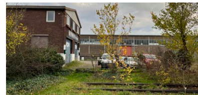
Aanvullend: Restanten van sporen, kranen en andere havenelementen
