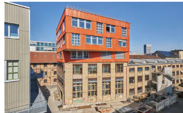
Nieuwbouw voornamelijk gemaakt van circulaire materialen: "All things that were already there plus wood, straw, and clay"
