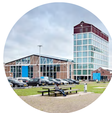
9. Nieuwbouw naast bestaand
