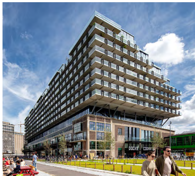
Optoppen met tafelconstructie
