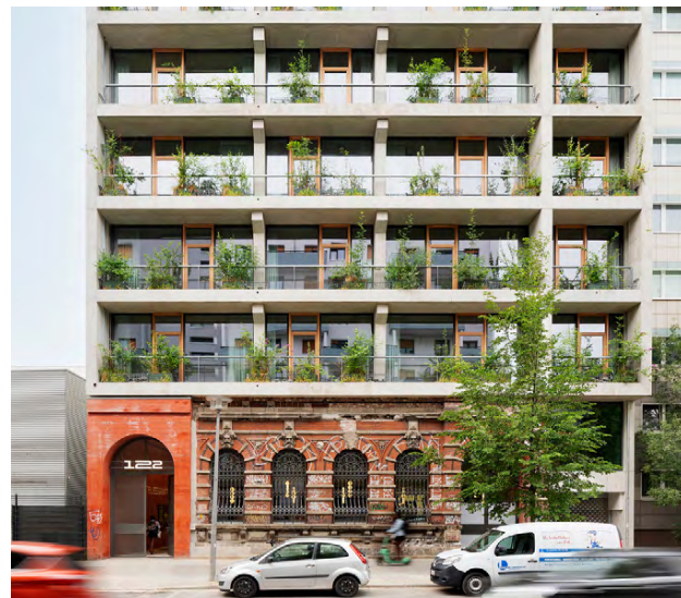
Nieuwbouw achter bestaande gevel
