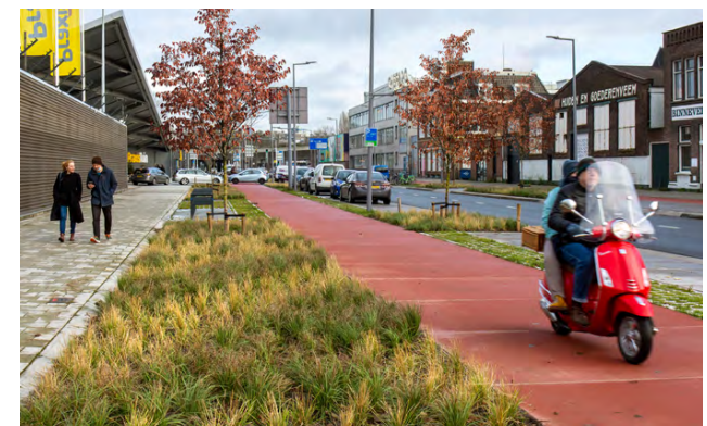
Wateropvang in het straatprofiel
