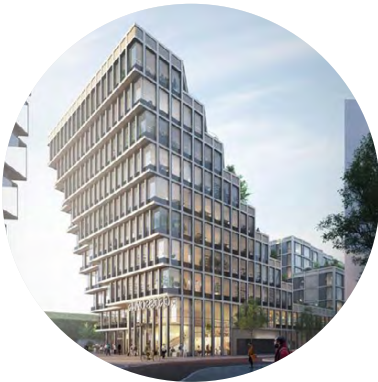
2. Iconisch gebouw op de kop van de pier
