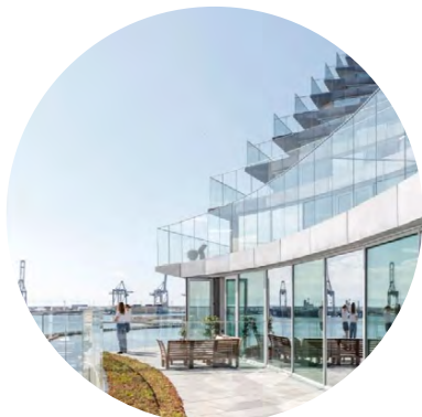
1. Iconisch gebouw op de kop van de pier
