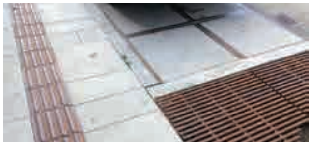
Bestrating in Nordhavn met beton en stelcon als basis
